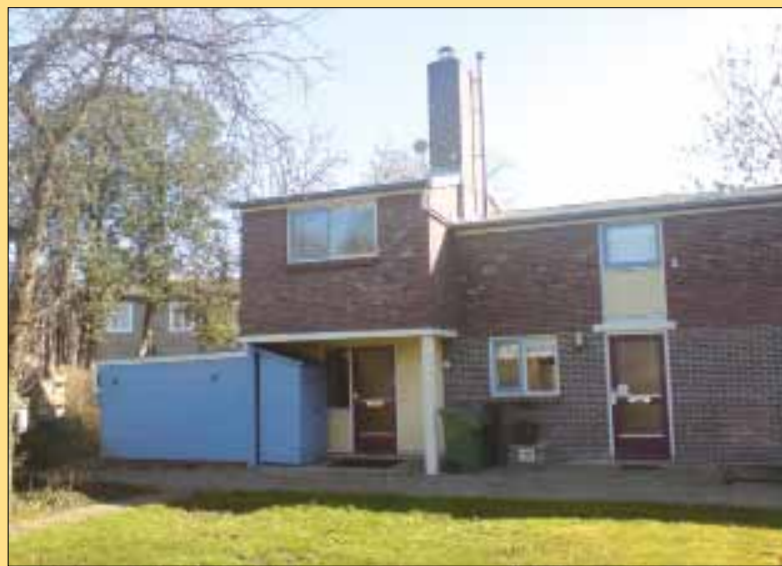
Het voormalige bejaardenhofje aan de Woldkade. Jammer genoeg kreeg het geen beschermde status.
